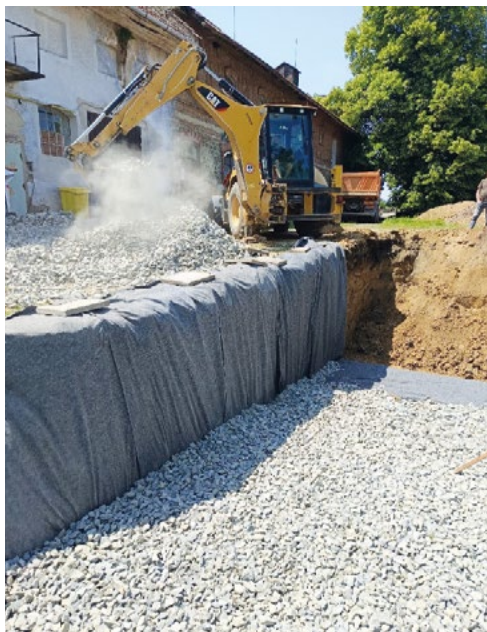
Budování retenční nádrže
