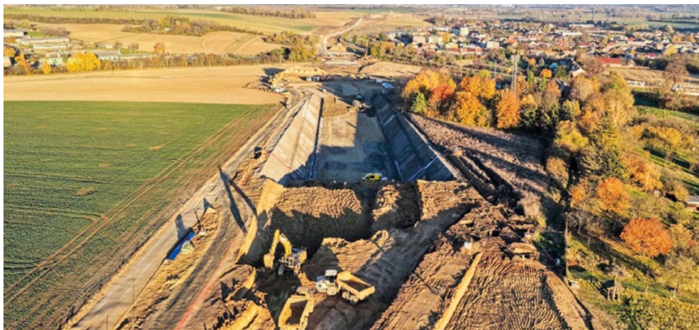
Kopání němčického tunelu
